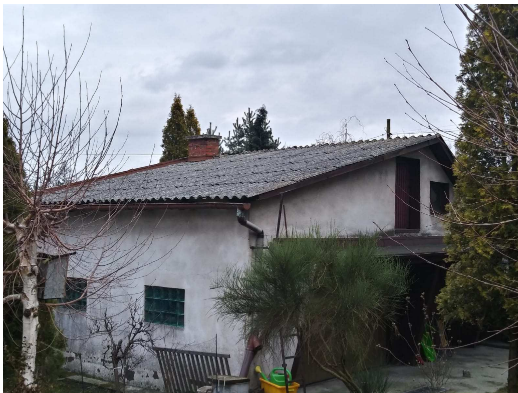
Rysunek 5 Dach pokryty płytami azbestowymi falistymi (budynek przykładowy)
